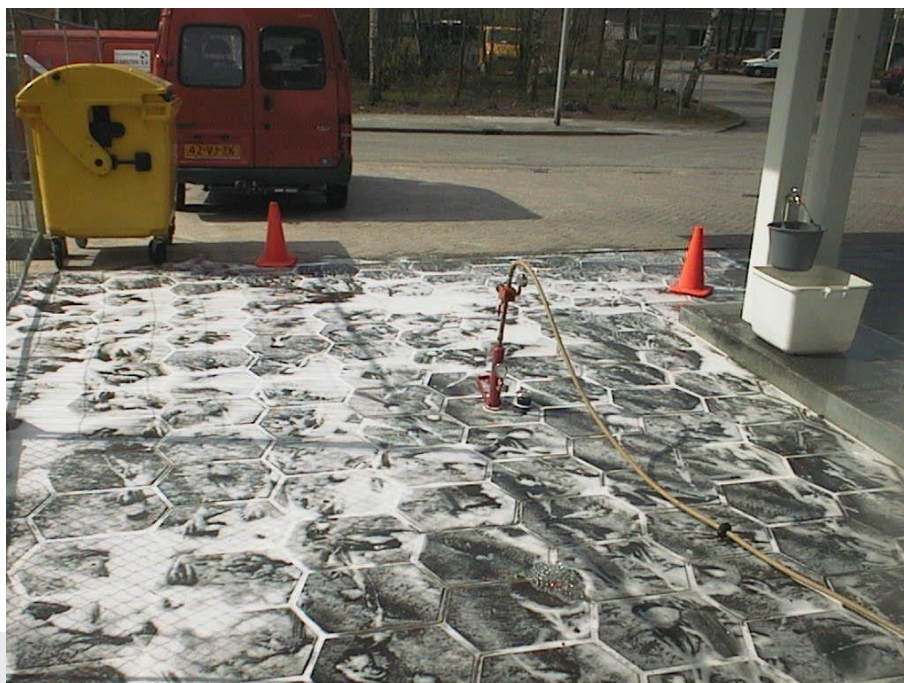
Foto: Inspectie uitgevoerd overeenkomstig protocol 6704.
