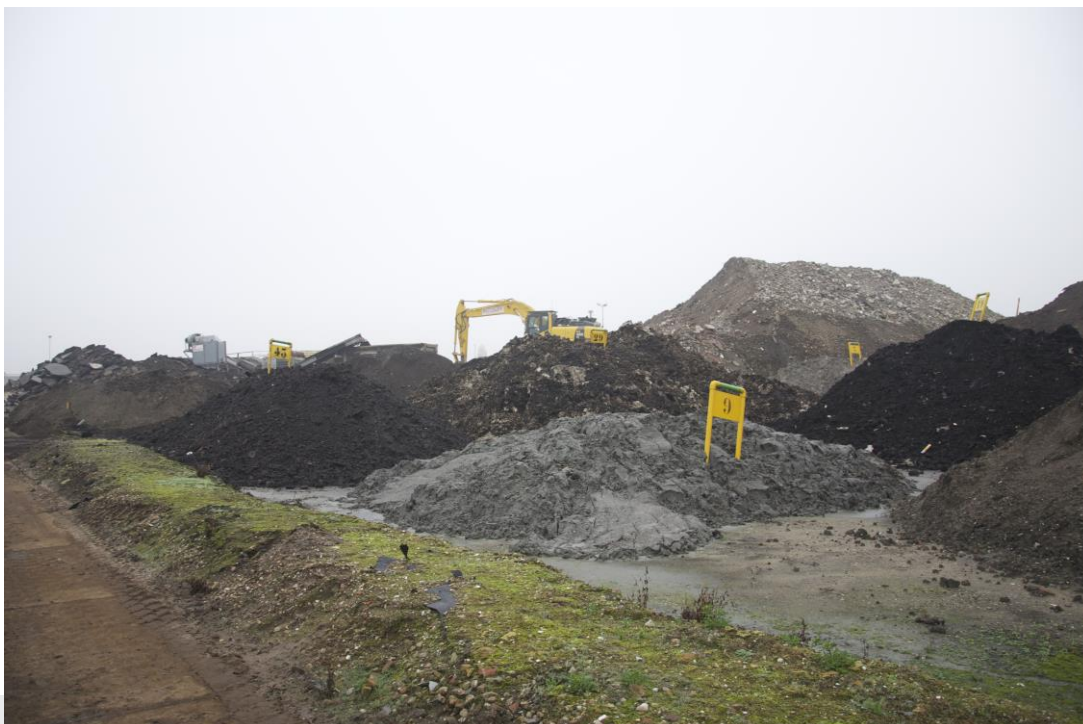
Foto: Mogelijke inspectielocatie voor geo-elektrische meting.
