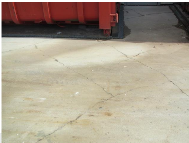
Foto: Voorbeeld niet-vloeistofdichte voorziening (scheuren).
