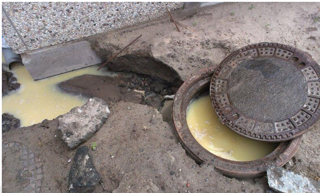
Foto: Verzakking in het rioleringsstelsel.
